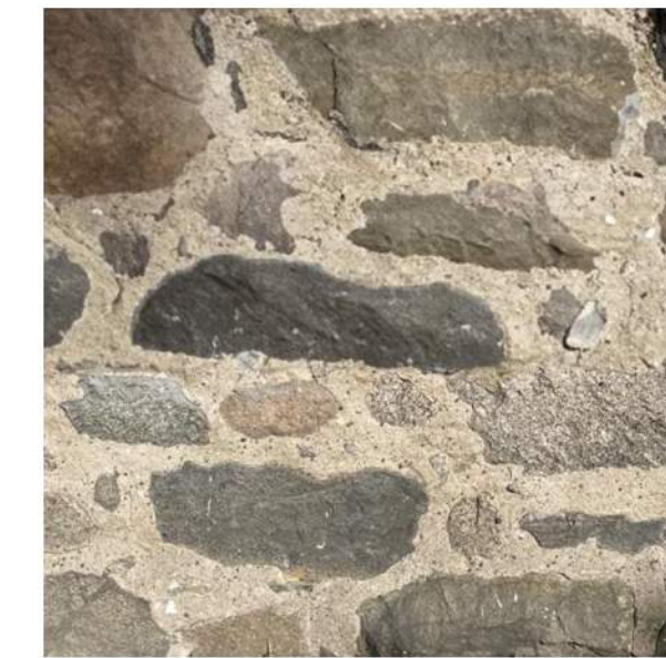
F1 EXISTING ROCK FOUNDATION WALL
