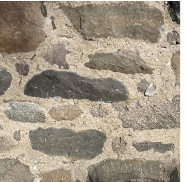
F1 EXISTING ROCK FOUNDATION WALL
