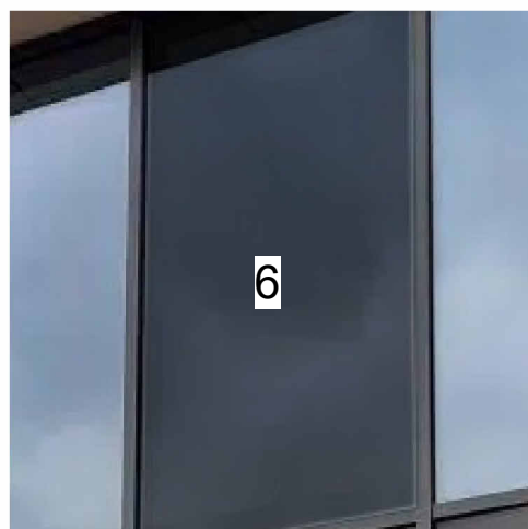
Aluminum Frame Spandrel
