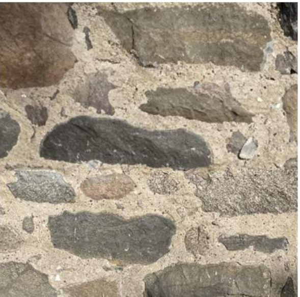
F1 EXISTING ROCK FOUNDATION WALL
